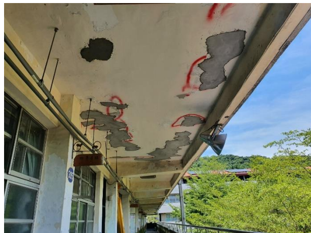
天花板整建工程 施工前
