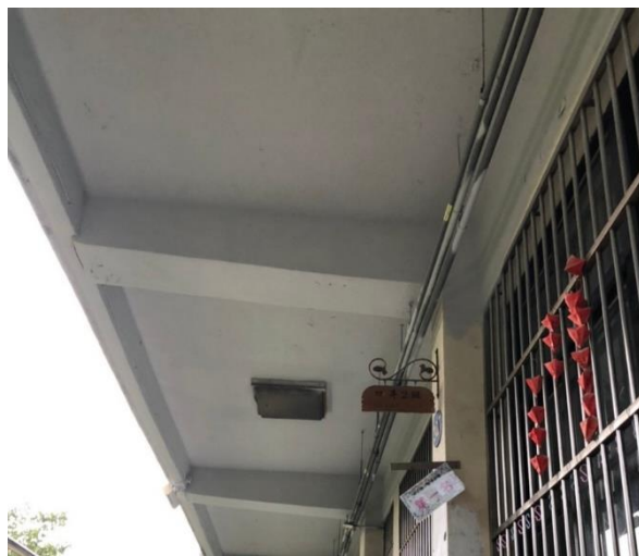
天花板整建工程 施工後
