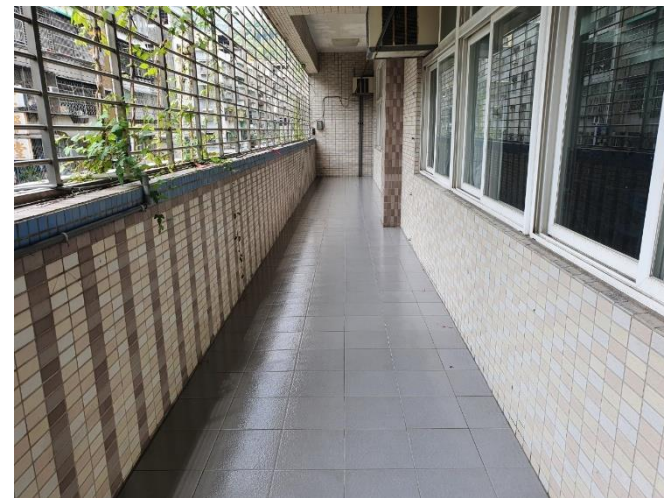
陽台地坪整建後
