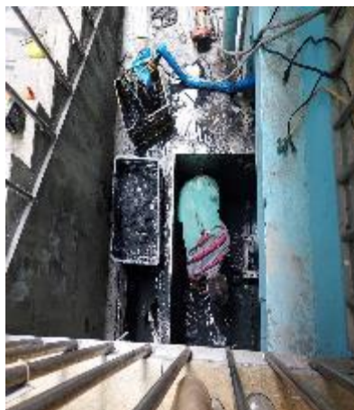
一般維護修繕：污水池清洗、給水管線更新並標註。
