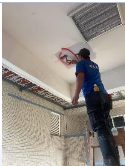
一般維護修繕：體健樓三、四樓鋼筋裸露處理。
